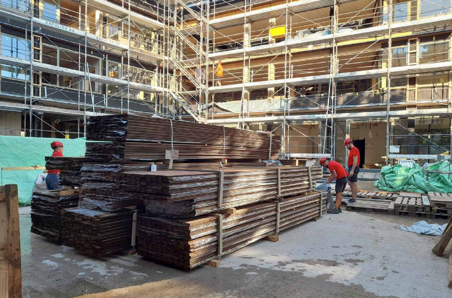
Das neue Dominikushaus: Ab Erdgeschoss aufwärts in Holzbauweise erstellt.
